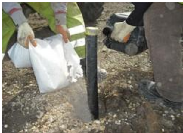
Bentonite hand pouring
